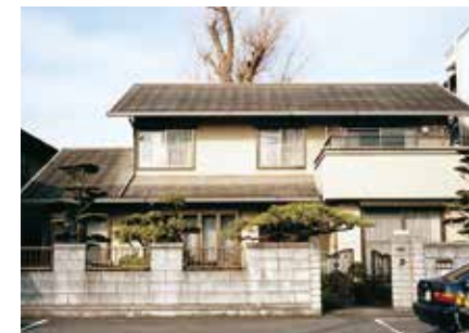
新設屋根：ロイヤル F・ブラック 既設屋根：着色スレート板 築15年 屋根面積：179m 2 工 法：カバー工法
