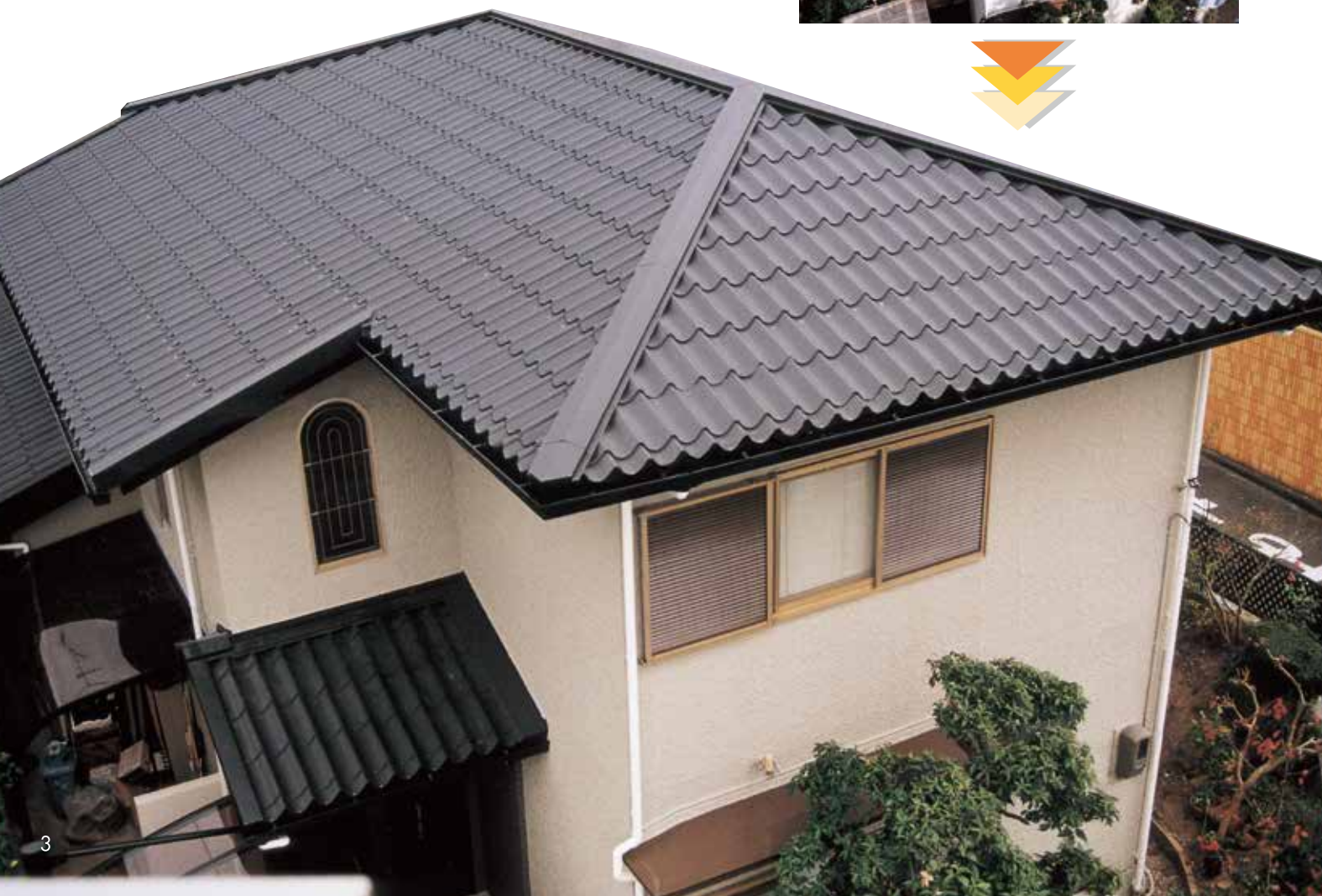
新設屋根：ロイヤル F・ブラック 屋根面積：117m 2 既設屋根：着色スレート板 築20年 工 法：カバー工法
