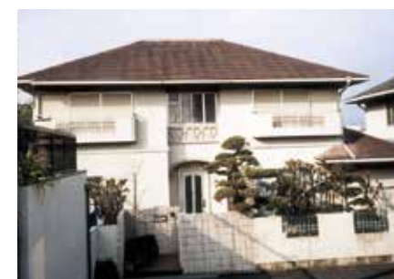
新設屋根：ロイヤル F・グリーン 既設屋根：着色スレート板 築16年 屋根面積：143m 2 工 法：カバー工法
