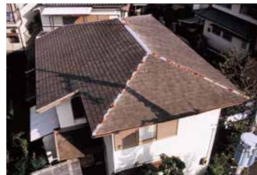
新設屋根：ロイヤル F・ブラック 屋根面積：117m 2 既設屋根：着色スレート板 築20年 工 法：カバー工法
