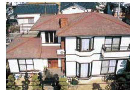
新設屋根：ロイヤル F・ブラック 既設屋根：着色スレート板 築17年 屋根面積：165m 2 工 法：カバー工法
